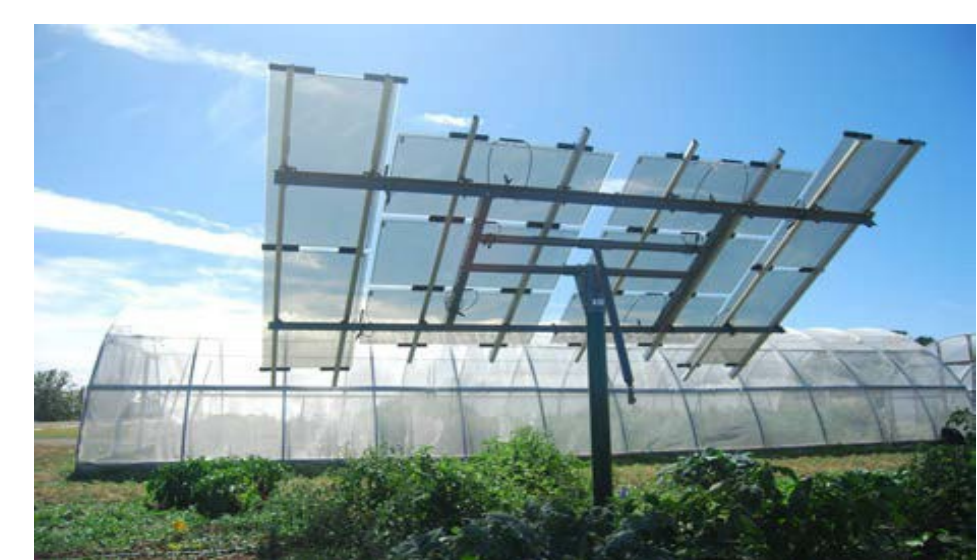
CdTe Semi-Transparent Module.
